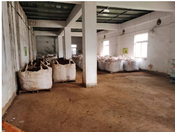
图 2-16 二厂 3-1#危废库内危险废物标识情况
