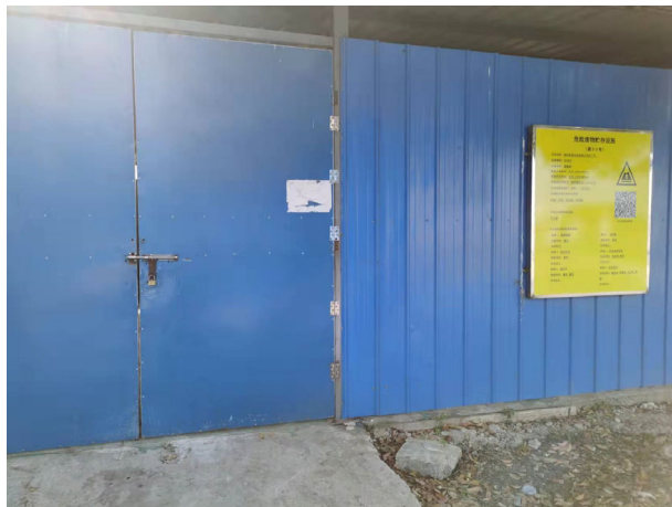
图 2-19 二厂 3-3#危废库门口标识情况
